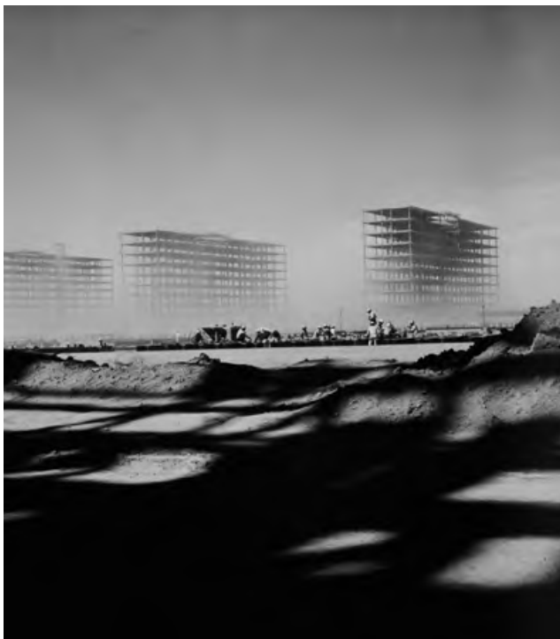
MARCEL GAUTHEROT. Esplanada dos Ministérios em construção, circa 1958.
