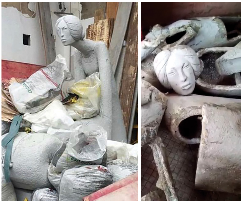
SITUAÇÃO DA ESCULTURA NO CANTEIRO DE OBRA E PARTES RESGATADAS DO “CONTAINER”
